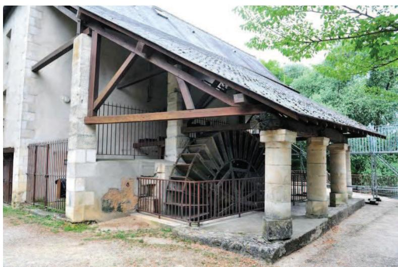
Le Moulin de Chasseigne accueille actuellement une base de canoë-kayak. La roue du moulin est encore en place et sera réhabilitée et équipée afin de produire de l'électricité. La production attendue est de 16 MWh/an pour une puissance de 2,5 kW, pour un investissement estimé à 30 000 €.
