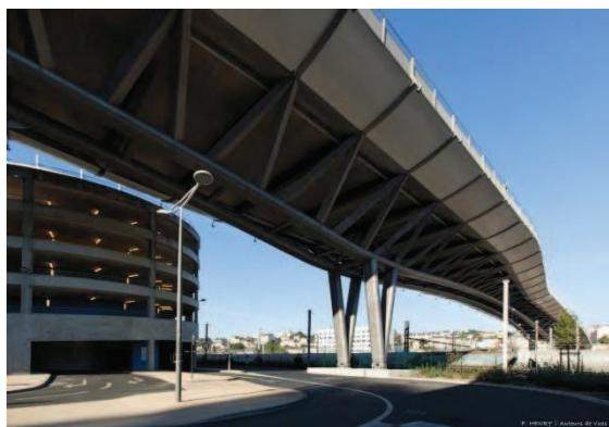
Le Viaduc Léon-Blum est un ouvrage d'art d'une longueur de 330 m et d'une largeur de 15 m. Il constituera l'élément essentiel des 3,46 km des lignes du Bus à Haut Niveau de Service (BHNS), reliant Poitiers Ouest au Centre-ville.
